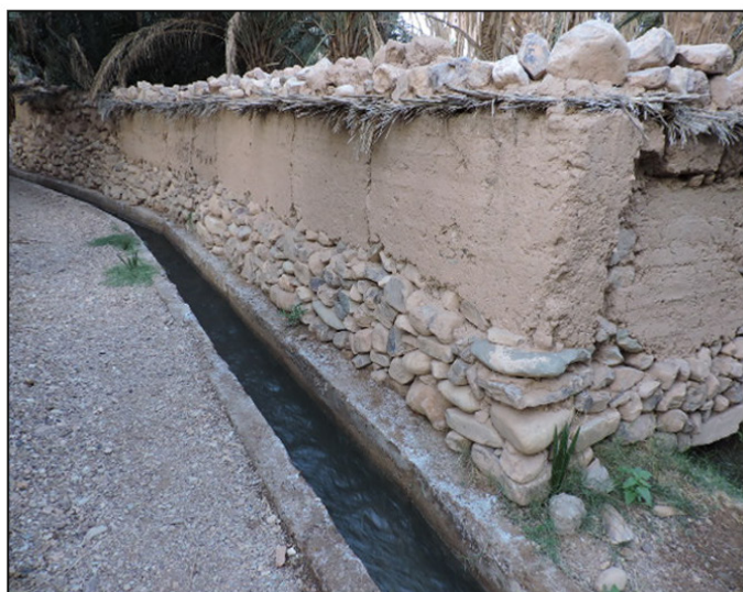
Figure 10: Photo et détail de construction d'un mur en pisé dans l'oasis de Fam Al Hisn
